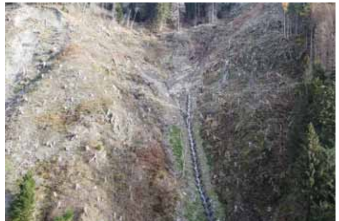
Die Konsolidierungssperren aus Stahl und Netzen.
