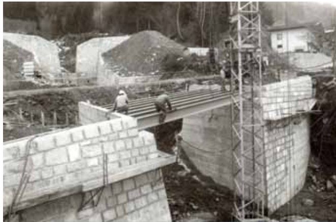
Die neue Egger-Brücke und die große Sperrmauer verschlangen viel Geld.
