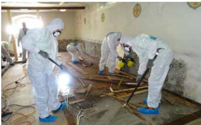
Entfernen des Holzbodens unter Sprühdesinfektion.
