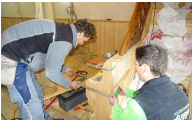
Arbeiten beim Stiegenaufgang.
