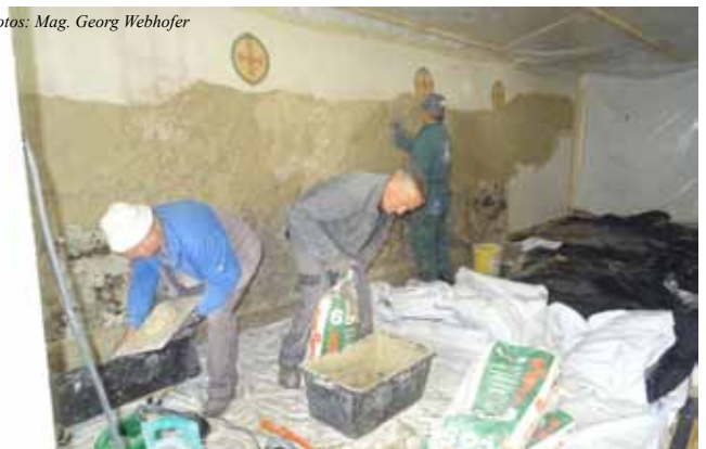
Erneuerung des Verputzes auf der Nordseite.
