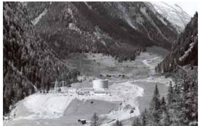
Die Pumpstation Gruben nahe dem höchsten Punkt der Leitung auf 1.550 m.
