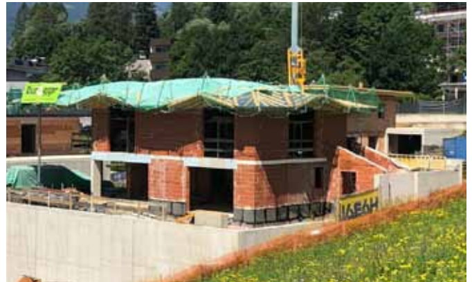
Neubau Wohnhaus Peheimweg 26
