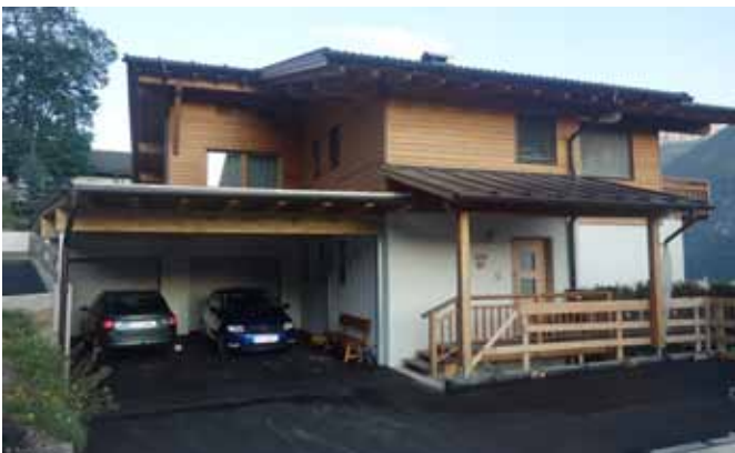
Zubau Carport beim Wohnhaus Untergaimberg 6
