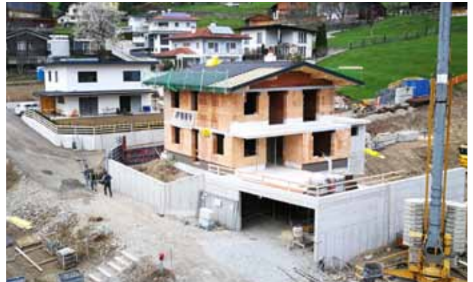
Neubau Wohnhaus Peheimweg 24
