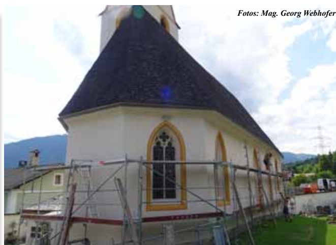
18.07.2019: Die Firma Troger baut das Gerüst beim Kirchenschiff ab.
