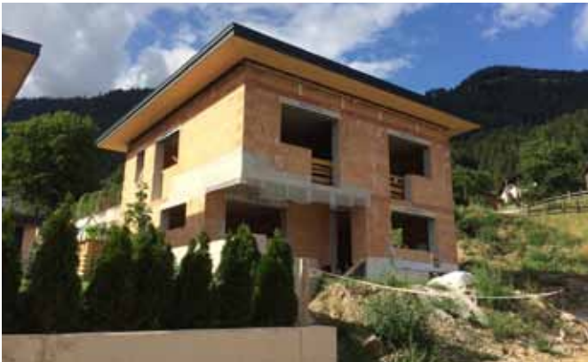
Neubau Wohnhaus Peheimweg 25
