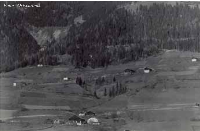
Hier sieht man links die neue Trassenführung durch den „Gorele“-Acker.
