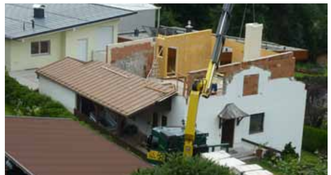
Um- und Zubau Einfamilienwohnhaus (Dorfstraße 28)
