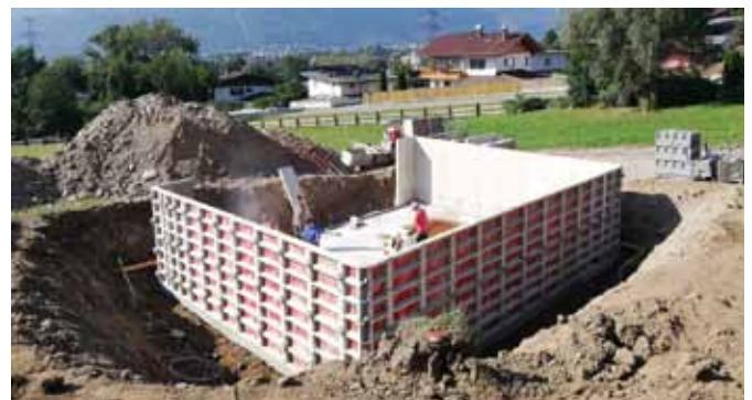
Neubau Einfamilienwohnhaus (Peheimweg)
