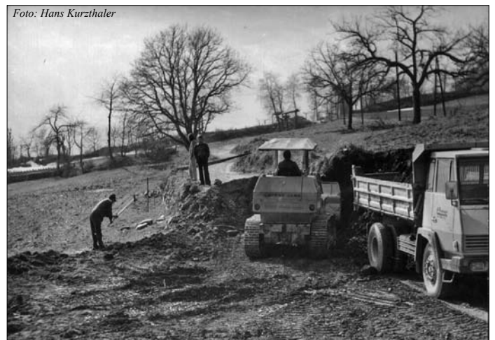
1977: Bauarbeiten am Rennweg. Am Foto: Viktor Zeiner, Adolf Possenig, Andrä Huber, Willi Lercher, Siegfried Waler. Die Chronik berichtet, dass die Arbeiten im Herbst 1976 begonnen und im März 1977 fortgeführt wurden. Am 21. November erfolgten die Asphaltierungsarbeiten. Nachmittags setzen starke Schneefälle ein. Die Arbeit wird zähe fortgesetzt, trotz Schnee und Dunkelheit, und größtenteils beendet. In den folgenden Tagen tritt Tauwetter ein, sodaß auch die restliche Kleinarbeit noch getan werden kann.
