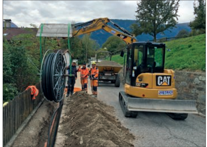
Bereich Renneweg: LWL-Leitungen werden auf Rollen mit Hilfe von Baggern verlegt.
