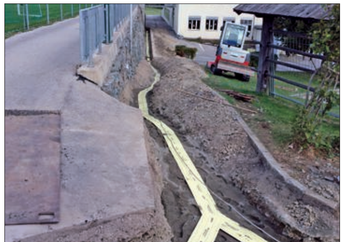
Bereich Gemeindezentrum: Hauptleitung zum neu errichteten Serverraum.
