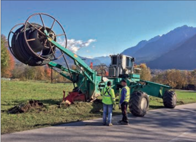
Von Patriasdorf bis Anthof Kreuzl wurde die Backboneleitung (Hauptleitung) eingepflügt.
