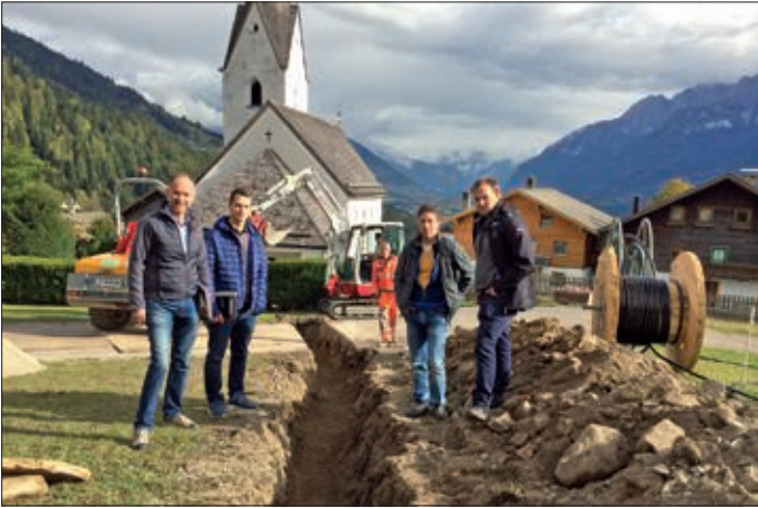
Regelmäßig werden Baubesprechungen vor Ort durchgeführt.
