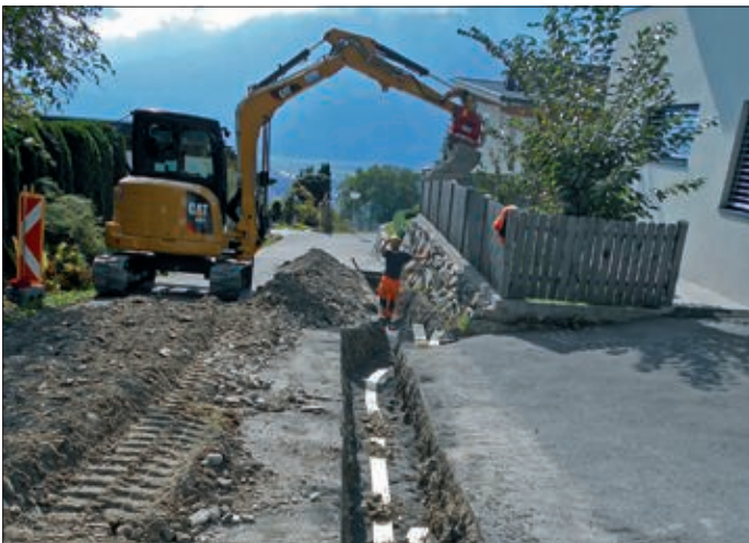
Bereich Weberlefeld: Sämtliche Leitungen werden mit Schutzplatten abgedeckt.
