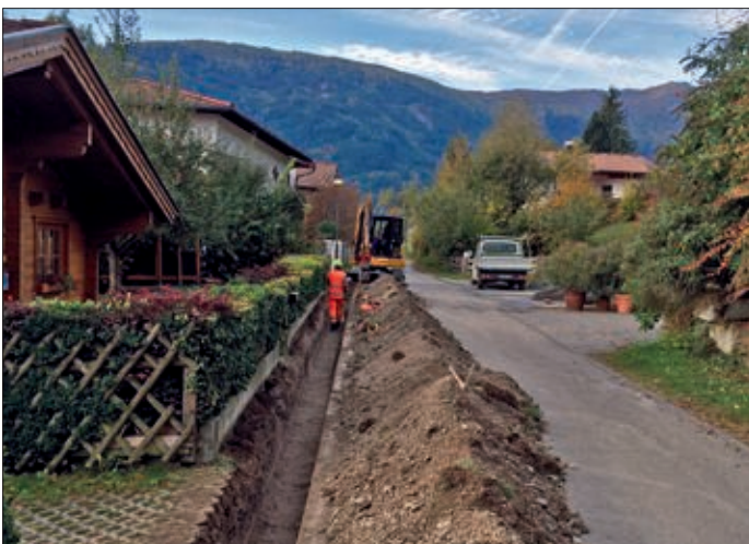
Bereich Wohnstraße: Wo dies möglich ist, werden die LWL-Leitungen und Leerrohre in Grünstreifen verlegt.
