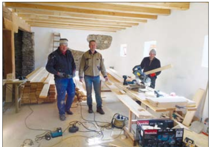
Feber 2015: Ein sägerauer Holzboden wird auf einer Unterkonstruktion verlegt.
