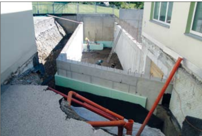
September 2013: Der neue Geräteraum entsteht zwischen Zentrale und Turnsaal.
