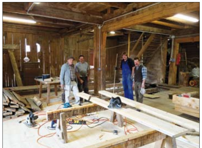
Juli 2014: Im vorderen Stall werden neue Holztrame und ein neuer Holzboden eingebaut.
