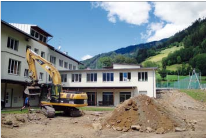
Juli 2013: Baubeginn: Entfernen des ostseitigen Stiegenaufganges und Grundaushub.
