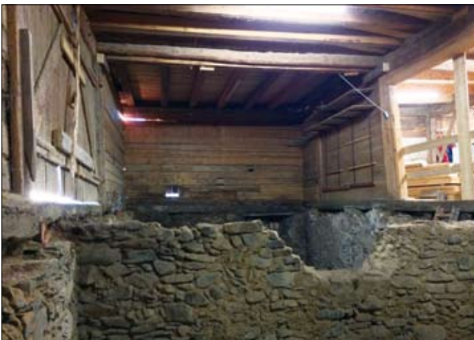
Dezember 2014: In den hinteren zwei Räume müssen die teilweise morschen Trame und die gesamte Decke entfernt werden.
