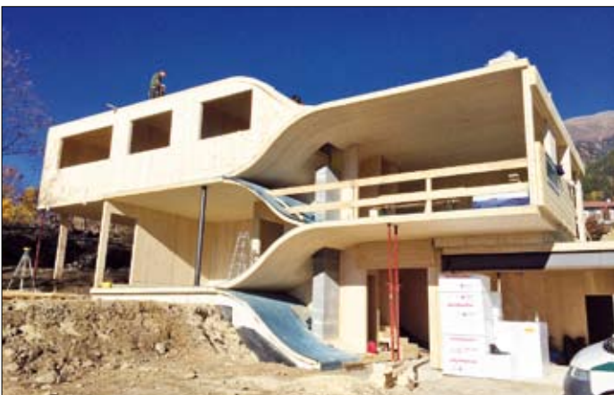
Familie Unterrainer errichtet im Weberlefeld ein Einfamilienhaus mit Garage und externer Sauna.
