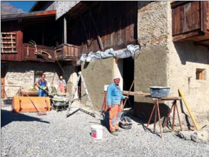
September 2014: Mauern zum Innenhof werden zugemauert und neu verputzt.
