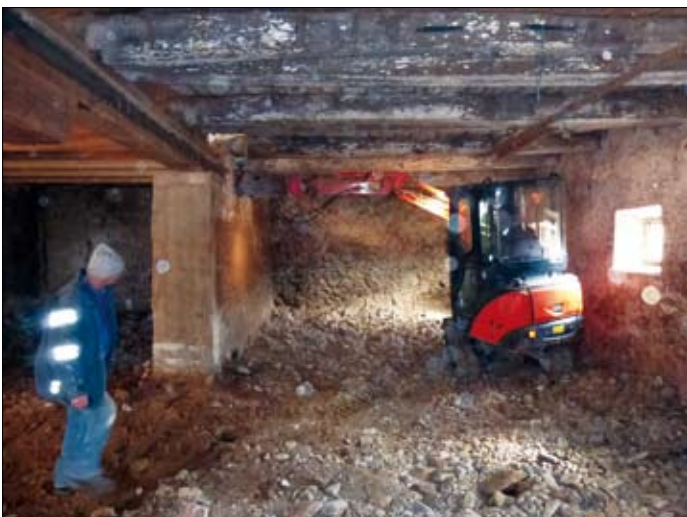
März 2014: Der Betonboden, Fundamente des Silos und eine Wand werden mit einem Bagger abgeschremmt und entfernt.
