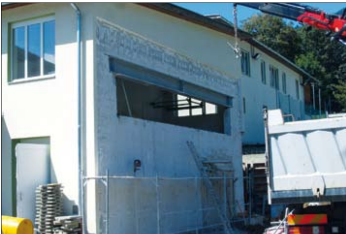
August 2013: Die Betonwand des Turnsaales muss in Einzelteile zerschnitten und entsorgt werden.
