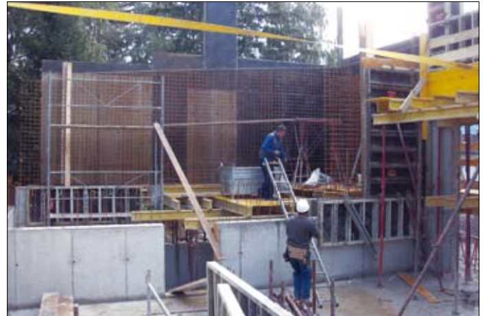
Oktober 2013: Betonarbeiten beim Pavillon und der Ausschank.
