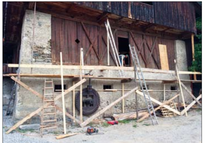
Juni 2014: Für eine schöne Außenansicht wird ein neuer Balkon errichtet.
