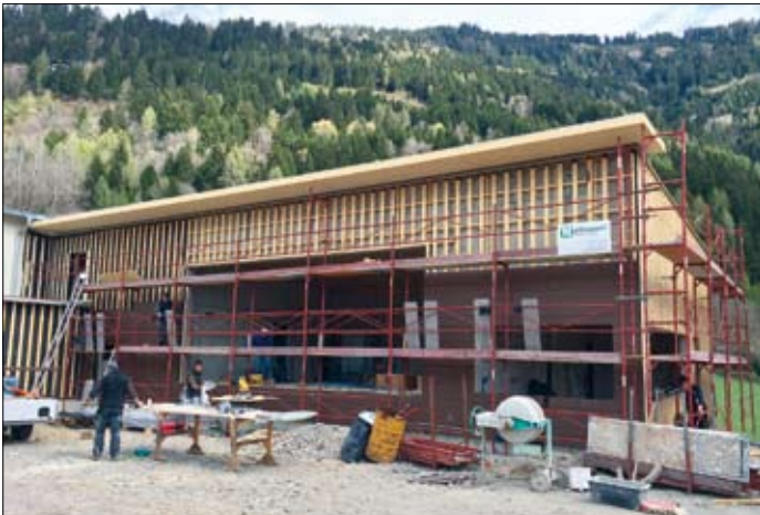
April 2015: Die Außenfassade aus Eternit wird montiert.
