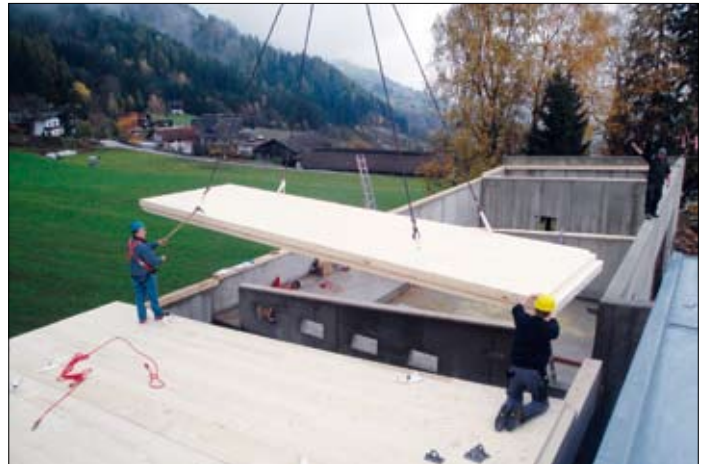
November 2013: Die Dachkonstruktion – dicke Massivholzplatten werden montiert.
