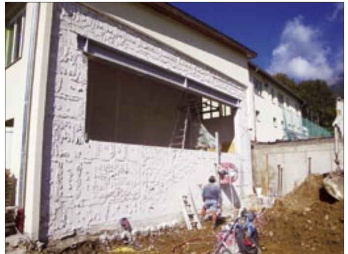
Die Betonmauer der Ostseite der bestehenden Turnhalle wird in Teilen heraus geschnitten. Die Öffnung wird für die neu zu errichtende Bühne benötigt.
