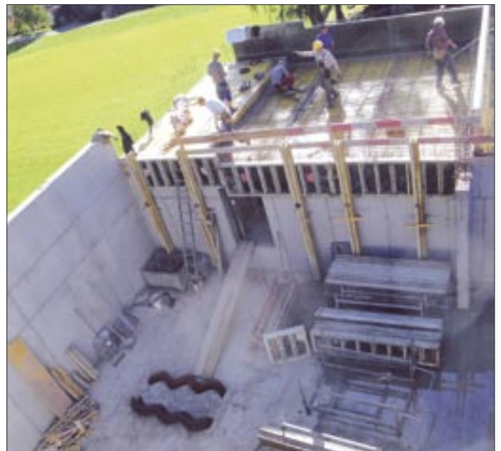
Blick von oben auf die neue Bühne und das Lager mit Durchgang und kleinem Aufenthaltsraum.
