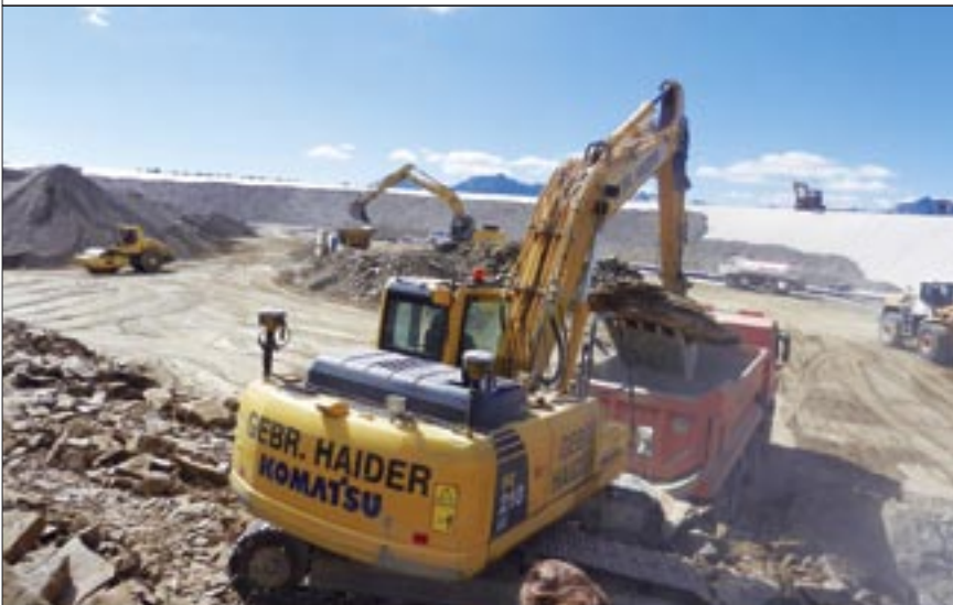
Sommer 2013. Viele Bagger, LKWs, Schabraupen, Walzen, Gesteinsbrecher usw. waren bei diesem großen Bauvorhaben notwendig. Der Speicherteich wurde von 71.000 m 3 Fassungsvermögen auf 132.000 m 3 vergrößert.
