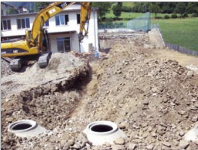
Errichtung der Versickerungsanlagen und Einbau von Wasserleitungen, Dachwasserableitungen und Kanalisierung.
