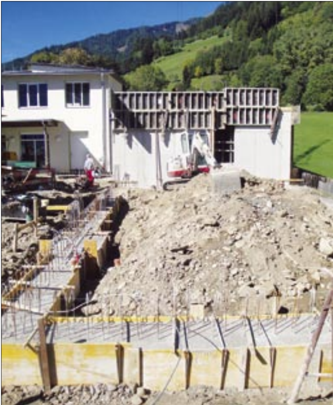
Fundamente für Lager, Pavillon und Ausschank.
