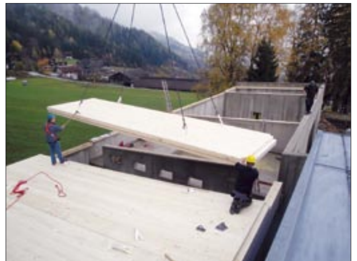
25 cm dicke Massivholzplatten (KLH) werden als Dachkonstruktion aufgesetzt.
