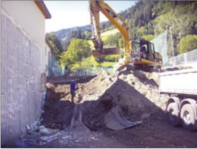
Baugrubenaushub für neues Gerätelager zwischen bestehender Turnhalle, Zentrale und Eisstockplatz.
