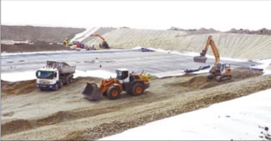
Sommer 2013. Viele Bagger, LKWs, Schabraupen, Walzen, Gesteinsbrecher usw. waren bei diesem großen Bauvorhaben notwendig. Der Speicherteich wurde von 71.000 m 3 Fassungsvermögen auf 132.000 m 3 vergrößert.
