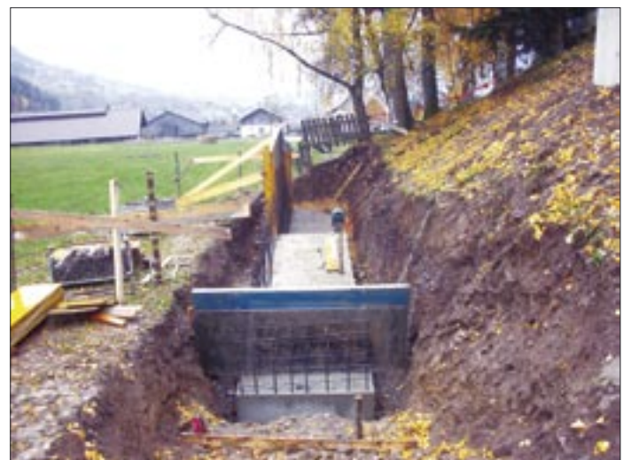
Die Errichtung einer Stützmauer gegen Osten.
