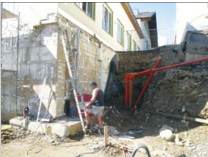
Der neue Zugang zum Gerätelager wird am Nordosteck der Turnhalle herausgeschnitten.
