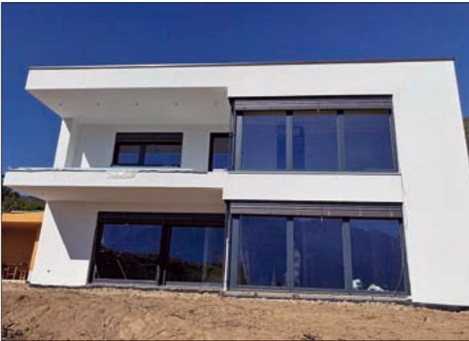
Patrick Kleinlercher errichtet im Weberlefeld ein Einfamilienwohnhaus (Baubeginn Mai 2018).
