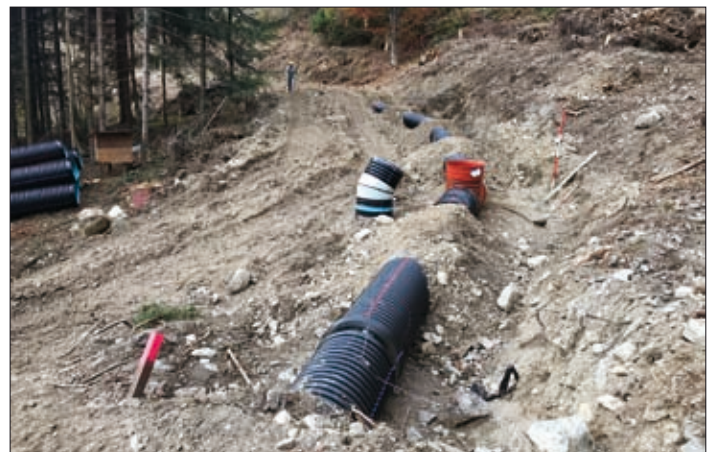
Im neu errichteten Forstweg ist ein Bypass (Abflussleitung) verlegt. Diese Rohre leiten bei Bedarf die überschüssigen Wässer in den Grafenbach ab.
