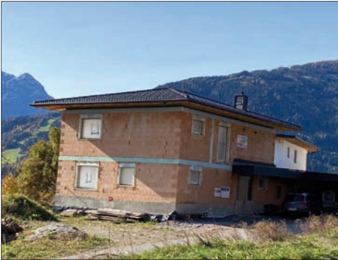
Bernd Gander errichtet im Weberlefeld ein Einfamilienhaus mit Carport (Baubeginn April 2020).
