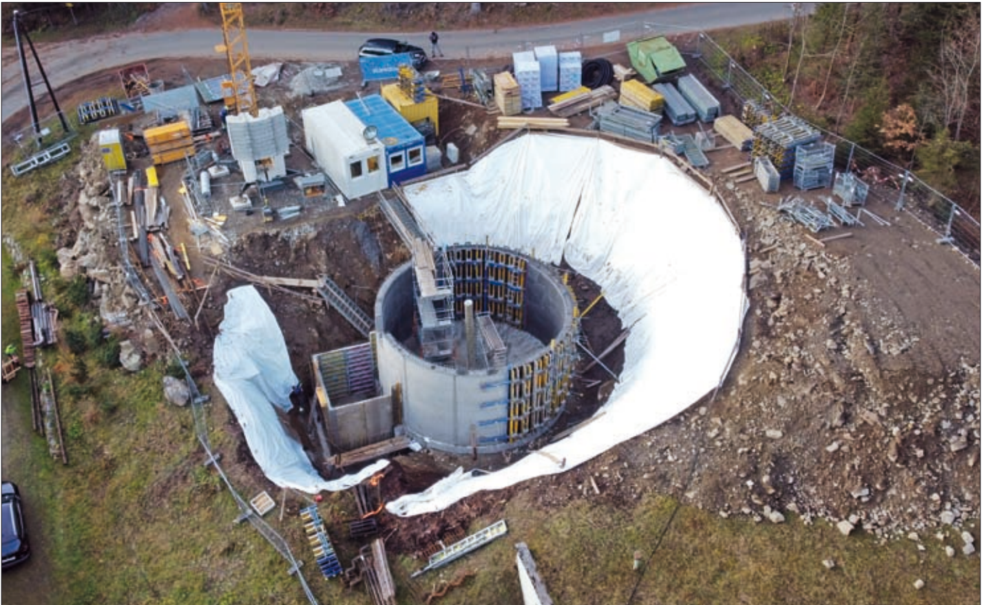
In einer Spezialrundschalung wurde der Behälter betoniert. Das geplante Nutzvolumen beträgt ca. 215 m 3 , Außendurchmesser 9,7 m, Innendurchmesser 9,00 m, mittlere lichte Höhe ca. 4,5 m. Links vorne entsteht eine zweigeschossige Schieberkammer, in welcher die gesamte Installation und die Überwachungssysteme eingebaut werden.
