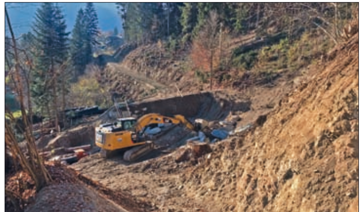
Errichtung des Geschieberückhaltebeckens in der Lampitze.
