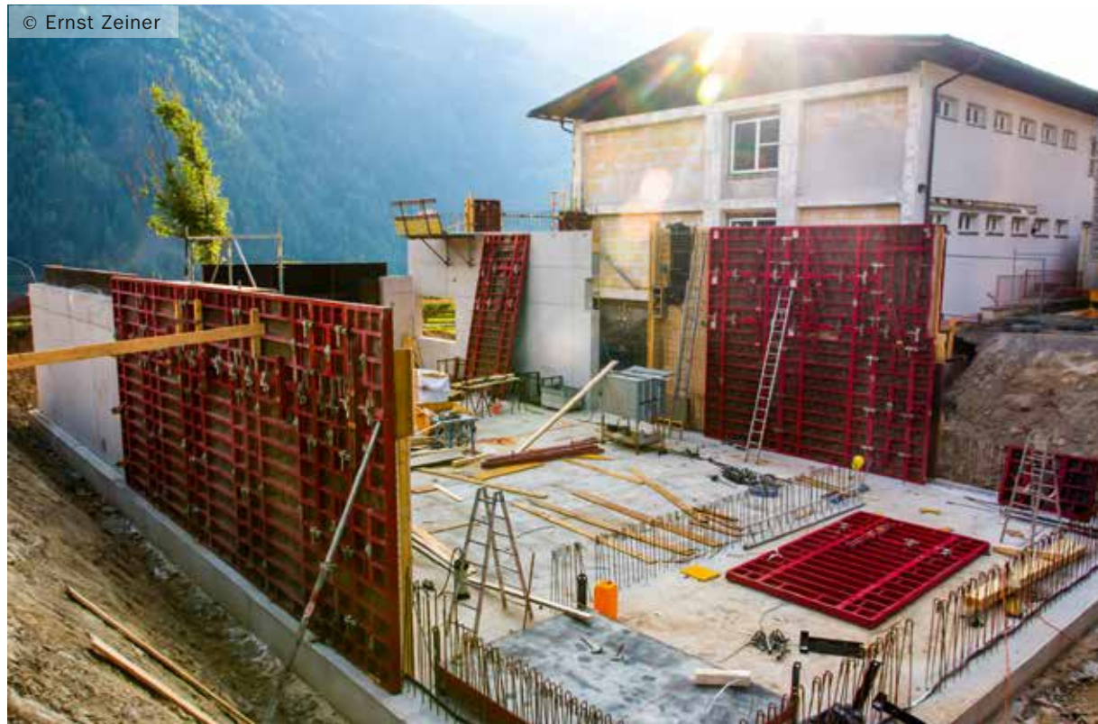
Der aktuelle Baufortschritt vom 20. August. Die Bodenplatte ist fertig und ein Teil der Mauern steht bereits.
