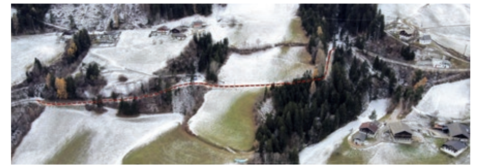
▲ Der Bereich vom Volksschulgebäude Glanz bis zur Mühlbachbrücke konnte fertiggestellt werden.
