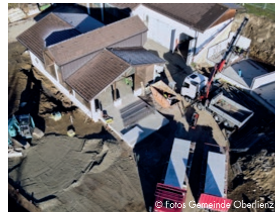
◀ Die Betonboxen für Grünschnitt, Sperrmüll und Altholz sind fertig und die Müllpressen für Plastik und Karton sind in Betrieb.
