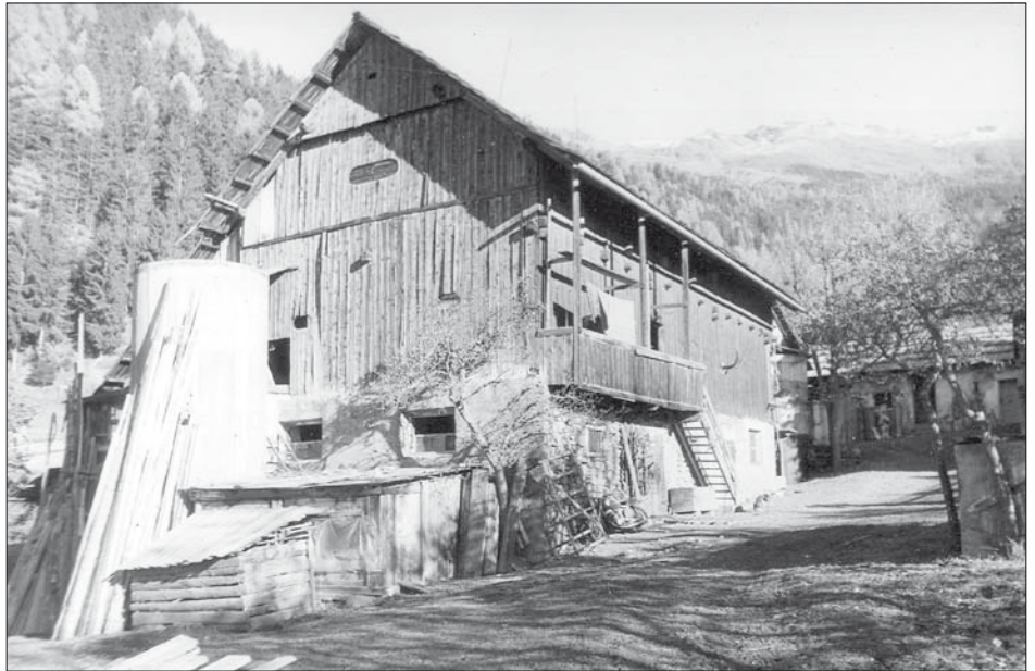
Der wieder aufgebaute Bartlerhof in einer Aufnahme aus dem Jahr 1973.
